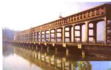
绵阳市三江水电综合工程拦河闸，15孔，过闸流量12300立方米/秒。
