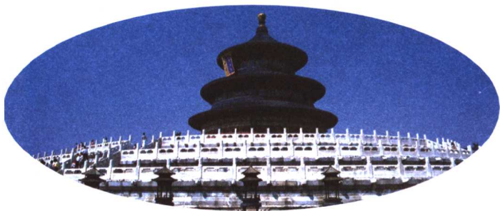
天坛充分显示了古代中国建筑工程的发达水平
