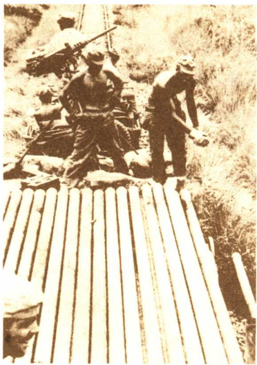
→ 工程技术人员在架设中印油管
