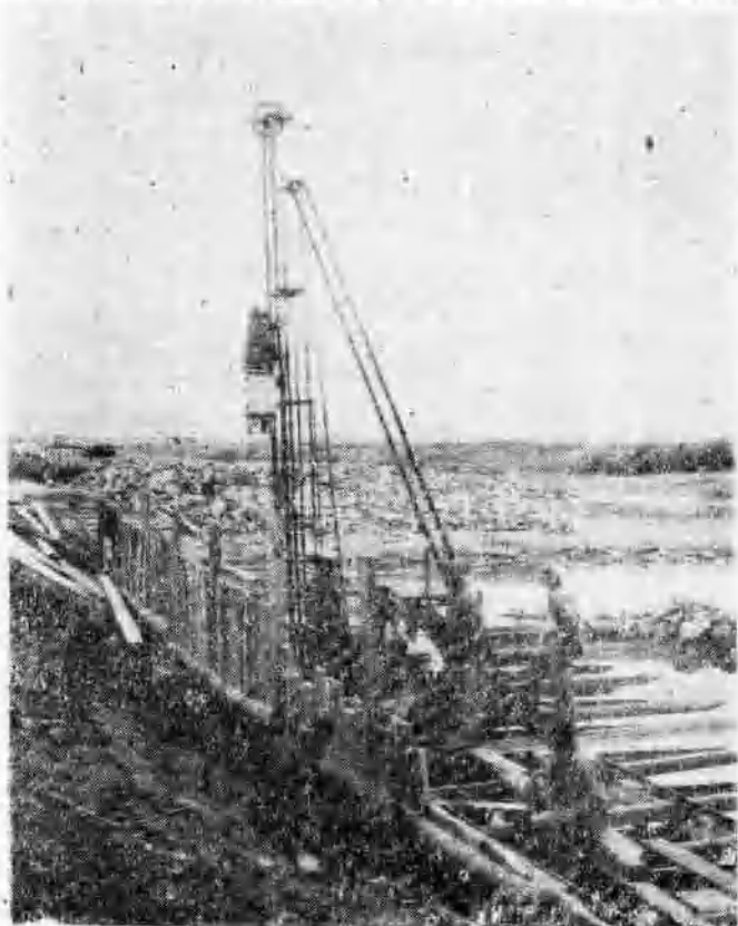
图4-1 打桩机正在進行打板桩徑20×5公分桩高35公尺，打桩效率2~4分/根
