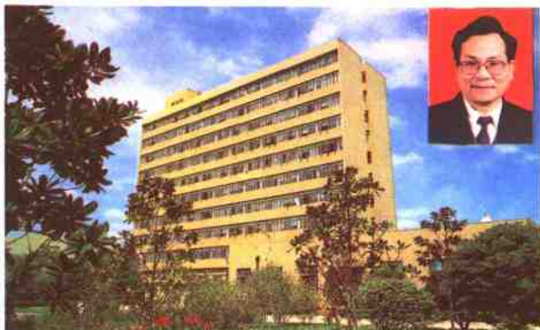
所長方向威及主樓外景
