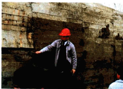
正在检查施工质量 机场建设公司总经理王应铨
