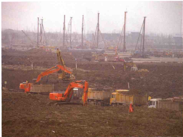
2003年3月土方堆载施工
