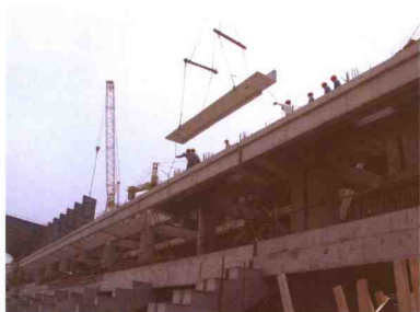
2003年6月主看台预制看台板吊装
