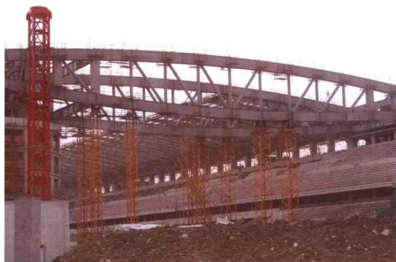
2003年8月空中餐厅与主看台 钢桁架吊装就位
