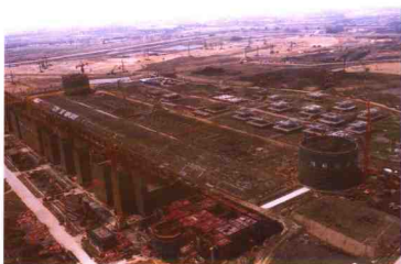
2003年4月主看台和车队生活区施工
