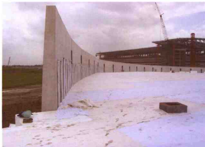
2003年8月挡土墙旁EPS摊铺施工
