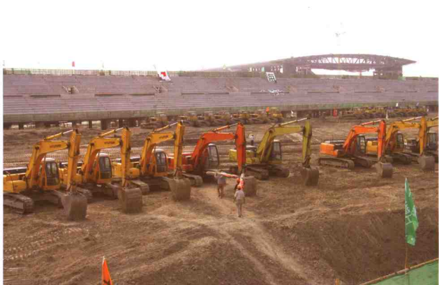
2003年10月赛道堆载区30万立方米土方卸载施工
