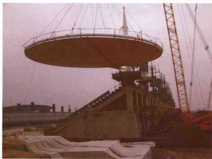
2003年11月副看台第一只膜结构 顶篷吊装就位
