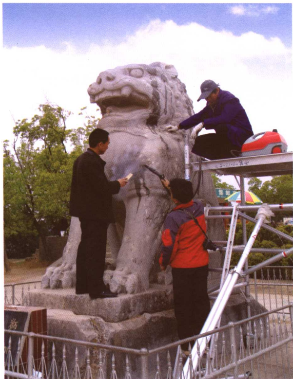
◀ 2006年3月20日，由西安文物保护修复中心、陕西省考古研究所与我馆共同承担的“中日唐陵石刻保护修复项目”之乾陵文物保护修复工程正式开工。图为石刻保护施工现场一角。
