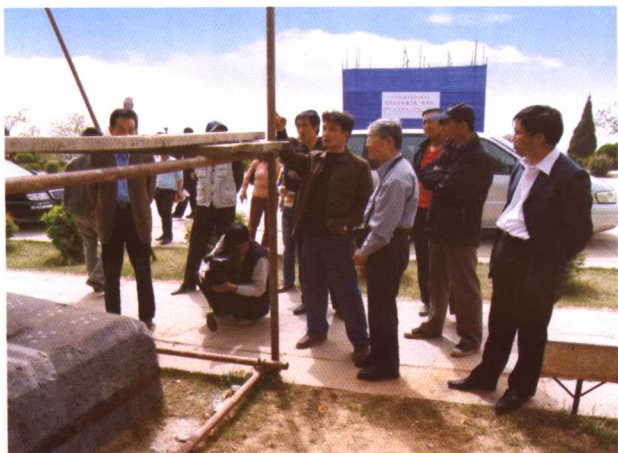
▲ 2006年4月18日，中日专家视察乾陵石刻保护工程现场。
