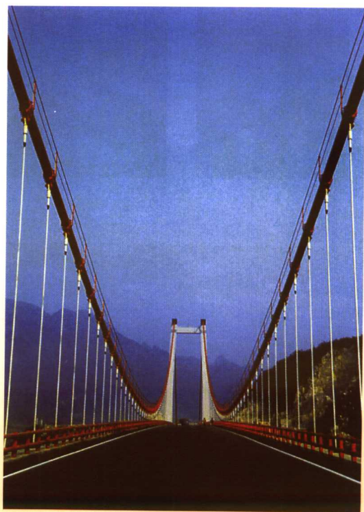
关兴公路北盘江大桥
