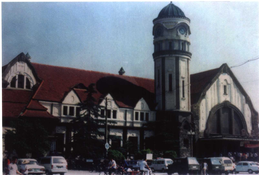
原津浦铁路济南车站。
