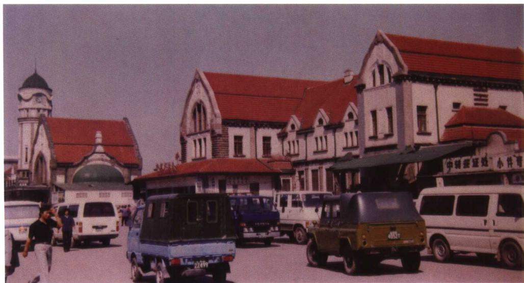
原津浦铁路济南车站行包房。
