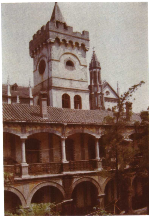
原天主教华北总修（道）院和钟楼。
