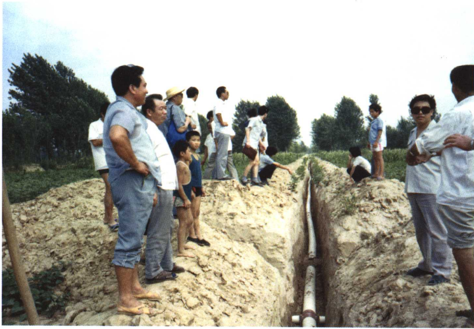
低压浑水管道灌溉工程
