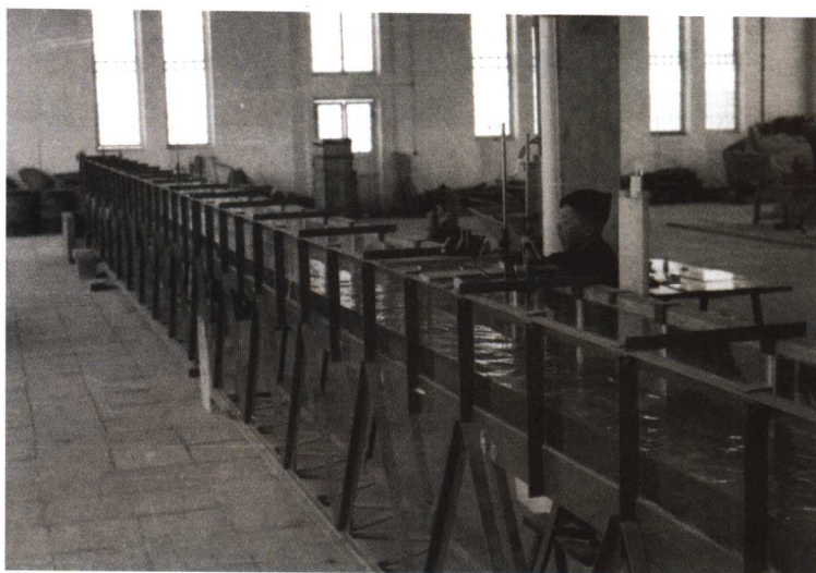
建于 20 世纪中期的 浑水试验水槽
