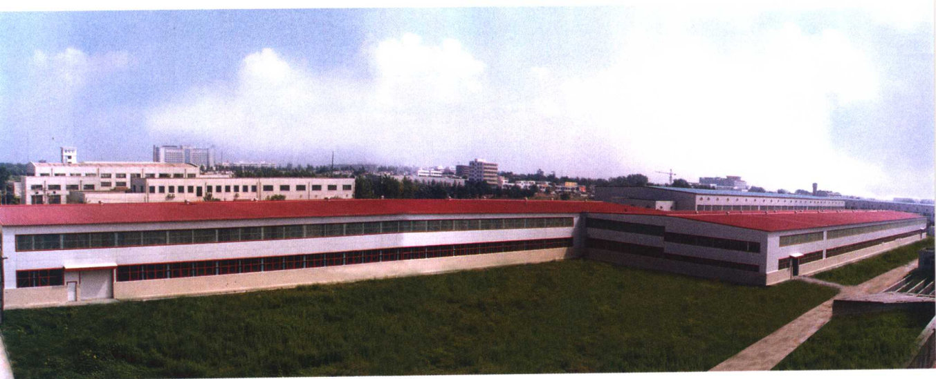
三门峡库区模型试验厅外景俯瞰
