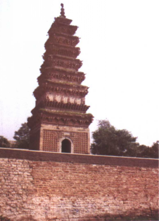
图11 临城普利寺塔 北宋 皇祐三年(1051年)始建，明嘉 靖二十四年(1545年)首次修葺， 位于临城北宋普利寺旧址。
