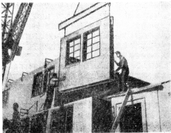
圖 5 在修建無骨架大型砌塊房屋
