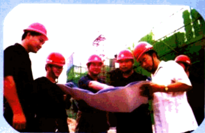
局领导深入施工一线现场办公
