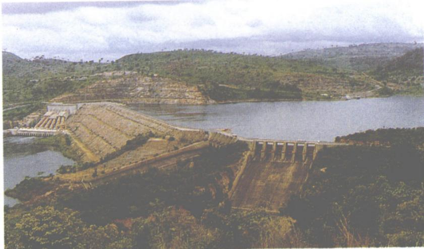
60年代，加纳人民在这里筑起一座长660多米、高130多米的弧形大坝，挡住了奔泻的沃尔特河水，大坝上方形成面积广达8480多平方千米的人工湖，并建起装机容量逾100万千瓦的大型水电站，这就是西非著名的沃尔特水利工程枢纽，照片为阿科松博水电站鸟瞰，所发电还输送到多哥、贝宁等邻国。
