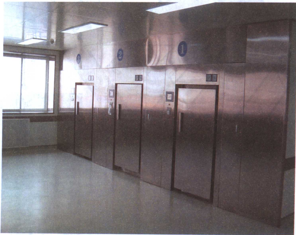
图 1-1 引出图 2 双扉式压力蒸气灭菌器将清洁区与无菌区隔开
