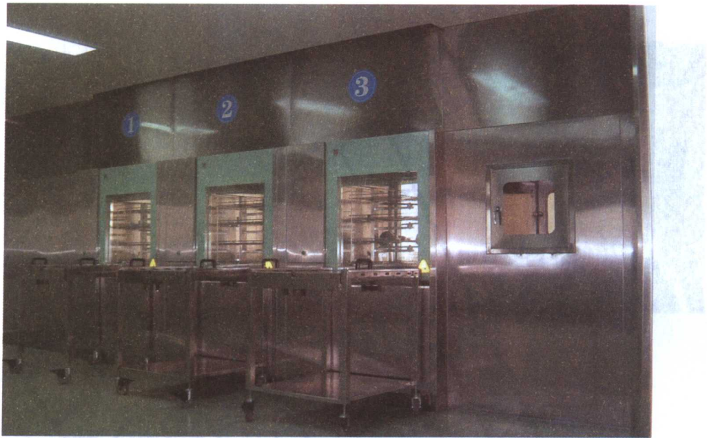
图 1-1 引出图 1 双扉式全自动超声清洗器将污染区和清洁区隔开
