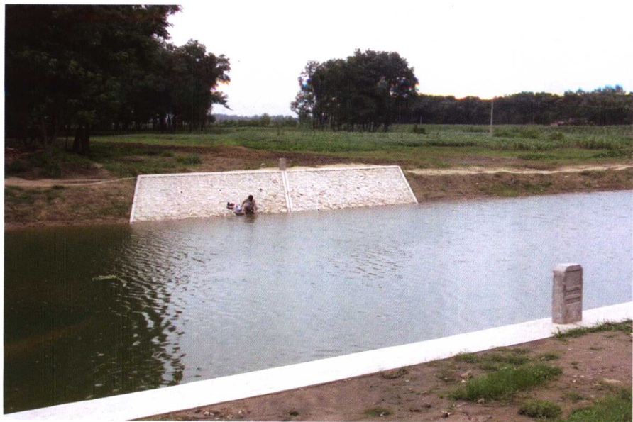
西气东输管道穿越水渠后的水工保护及地貌恢复情况
