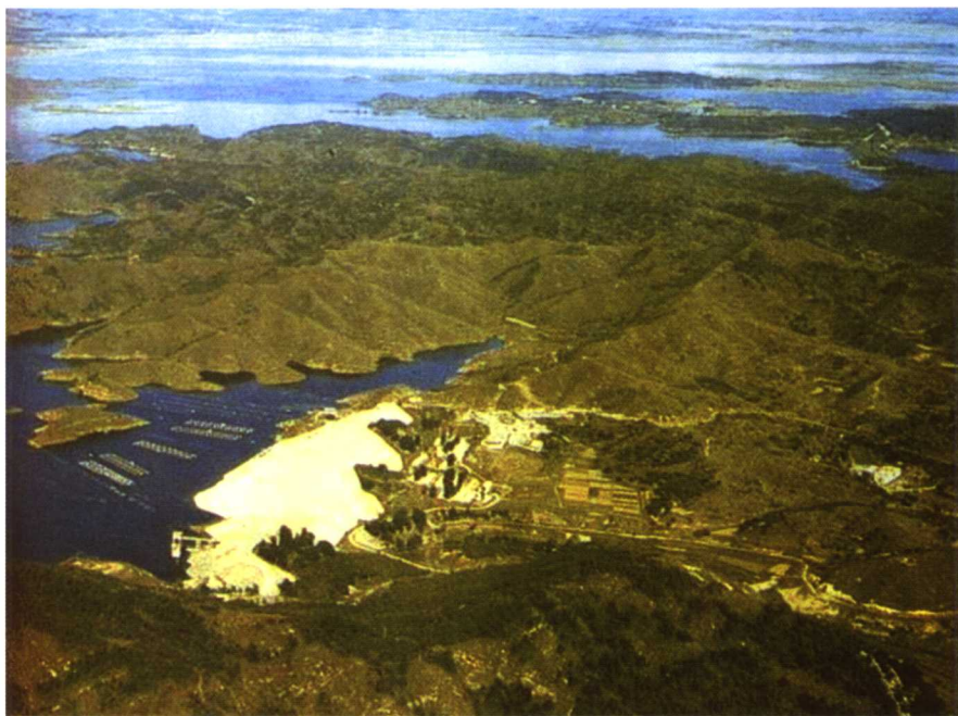
图 8-3 密云水库潮河大坝四周的植被覆盖
