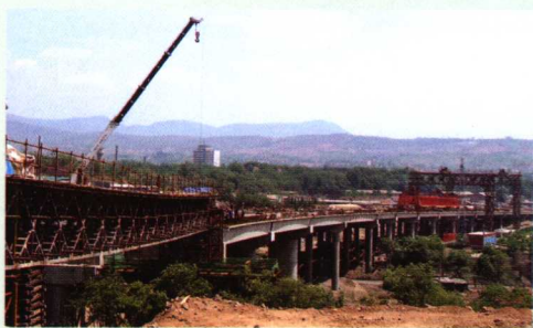
横跨石太铁路、白荫铁路支线和207国道，全长526米的义白路桃河特大桥
