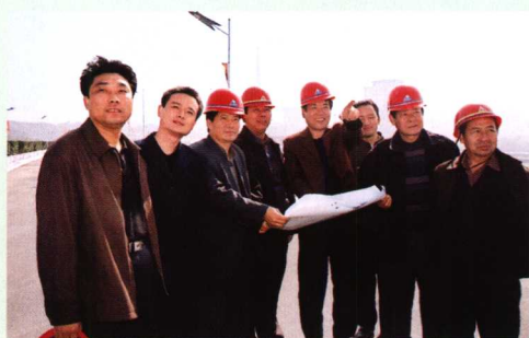
项目部领导和工程技术人员深入工地现场办公
