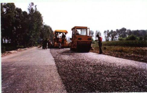
精心施工，不断提高路况质量和水平
