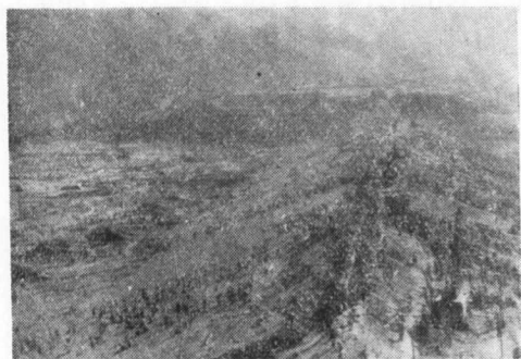
正在兴建中的水库拦洪大坝。 蓄水后图片左面均被淹没。
