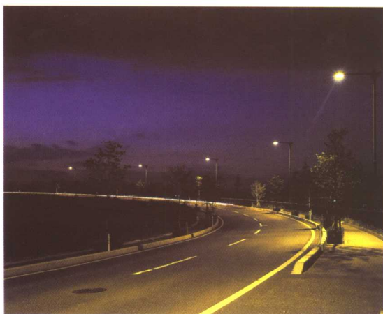
图 26 在道路的曲线路段上,将灯具沿曲线外侧布置,既有利于获得更高的路面亮度,也有利于建立良好的视觉诱导
