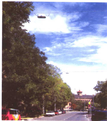
图 57 在树木特别茂盛的道路，可选择横向悬索照明方式
