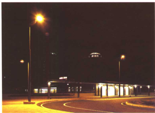
图 40 道路转弯处的灯杆上增设专门用于照明人行道的灯具,以便让此处的路型更清楚,也有效提高了道路照明的环境比
