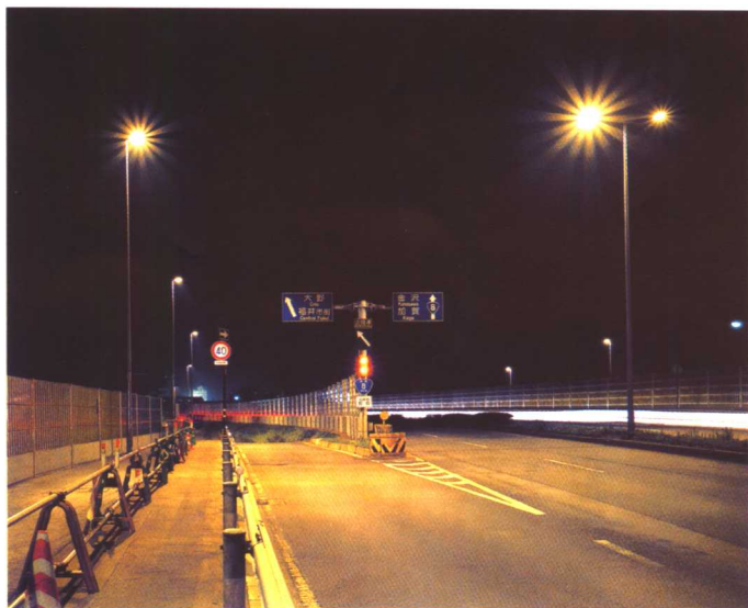
图70 采用针对性照明使道路分线处的路型、隔离带、地面标线、指示牌等得以清晰显现；分道隔离带端部的闪烁标志灯给了驾驶员有效的提示
