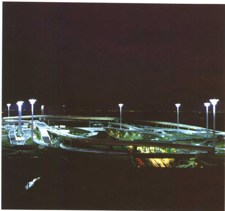
图 64 采用高杆照明方式为立交提供照明
