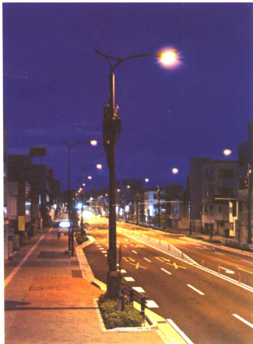
图15 临时停车带的前后两端设置了灯具，以便在无车辆停泊时能充分显现路面标线。在有车辆停泊时能将其照亮，方便其他人观察
