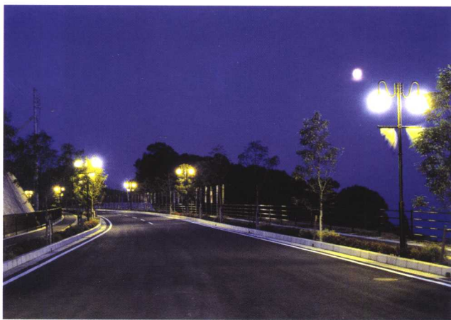
图10 主要供行人使用的道路上的步道灯
