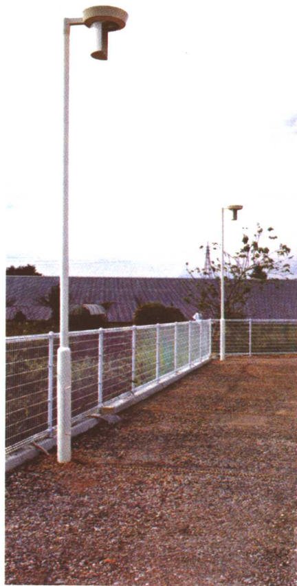
图 67 灯具出光口后面加装遮光板，防止光线后溢，避免干扰环境
