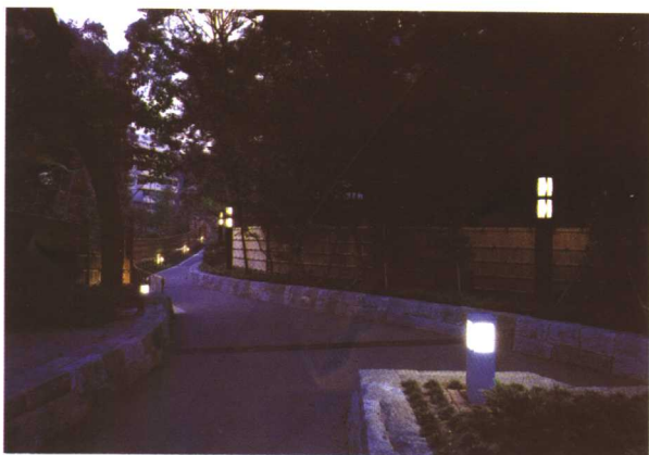
图46 在步行甬道上配合使用不同高度的灯具，兼顾了路缘提示和行人面部特征识别的需要，又营造了活泼的气氛
