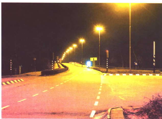
图20 在道路交叉口处设计的照明，要让各种道路标志（路缘石、路缘标志杆、地面标线）充分显现出来，以便于驾驶员能清楚地了解道路的形式和走向
