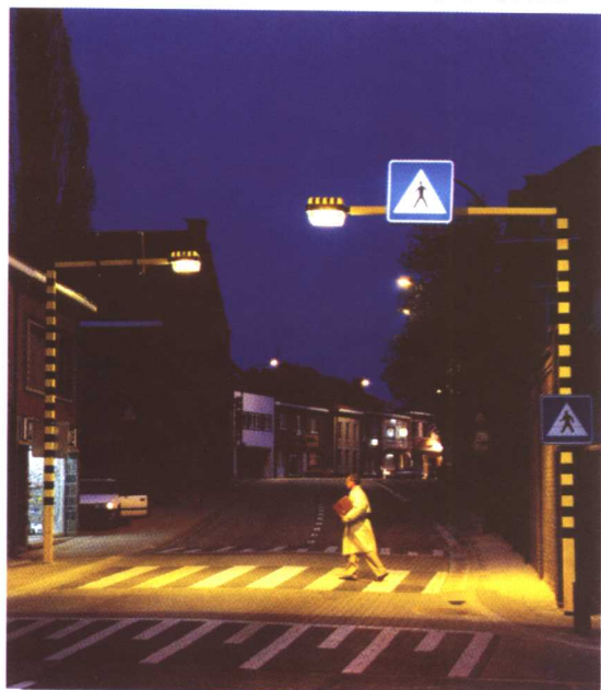
图50 超长的灯具悬臂充分保证整个人行横道获得均匀的照明。灯杆灯臂上漆成的警示性颜色以及高挂在悬臂上的指示牌，能给驾车人以有效的提示
