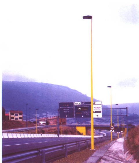
图71 快速道路危险区段上的路灯灯杆采用了带有警示性的颜色，以提示驾驶员注意
