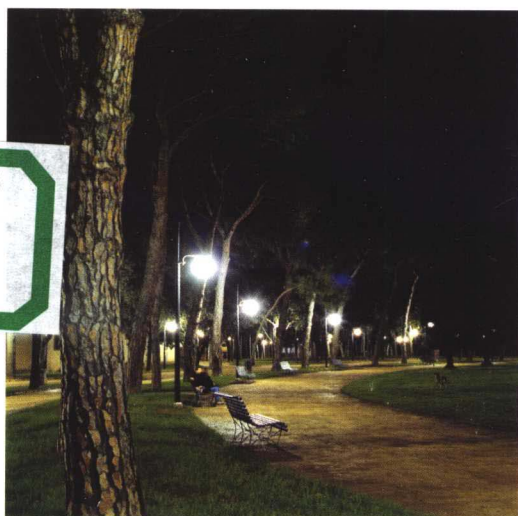
图4 公园小径的步道灯，通过选择光色特性、配光方式及安装位置，为通道和坐椅提供了适宜的光照，也让绿地和树木显现出自然的形貌，形成了让人愉快的氛围
