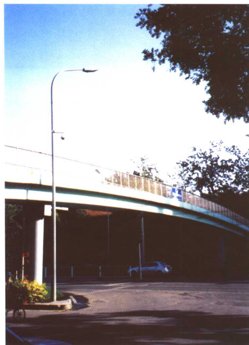
图 62 借助被跨越道路上的常规照明灯具来为人行过街天桥提供照明
