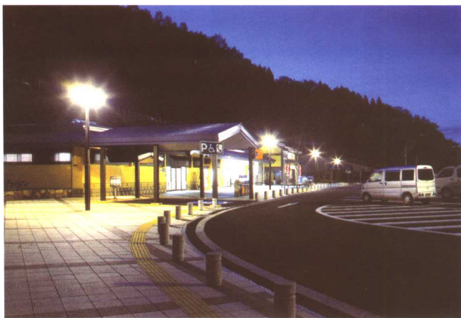
图 43 道路照明灯具兼顾了起隔离作用的挡车石桩的照明,使这一庇护性边界得到强调
