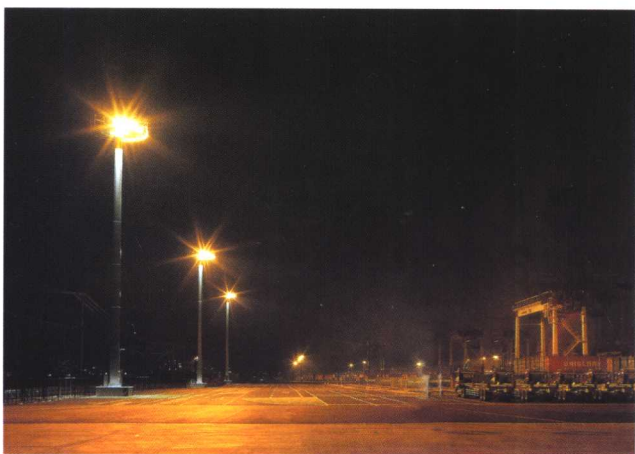
图12 用于城市广场等大面积区域照明的高杆灯
