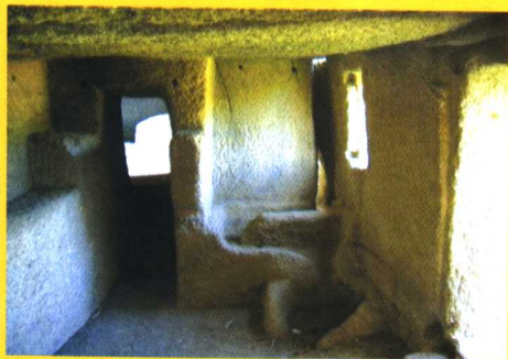
洞窟内皆为平顶，门、窗、炕、灶、排烟道、壁龛均一次性凿成
