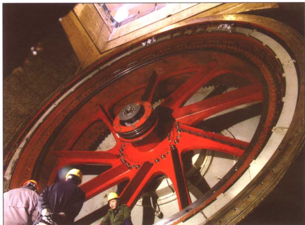
电站机组发电机检修
