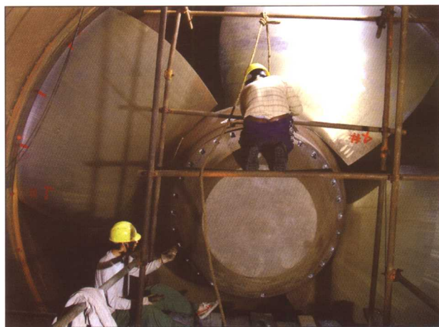
电站机组转轮维修
