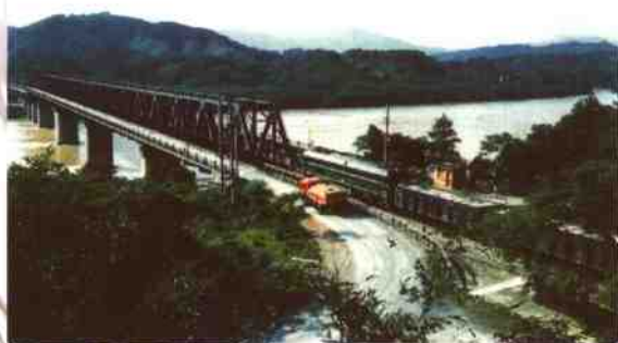
◀ 横跨融江的铁路、公路两用大桥
