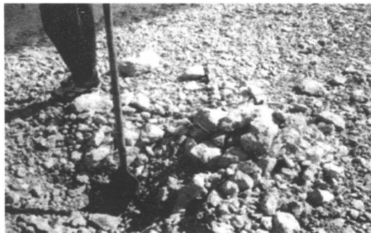
图 1-4 破碎后试坑开挖检查颗粒粒径
