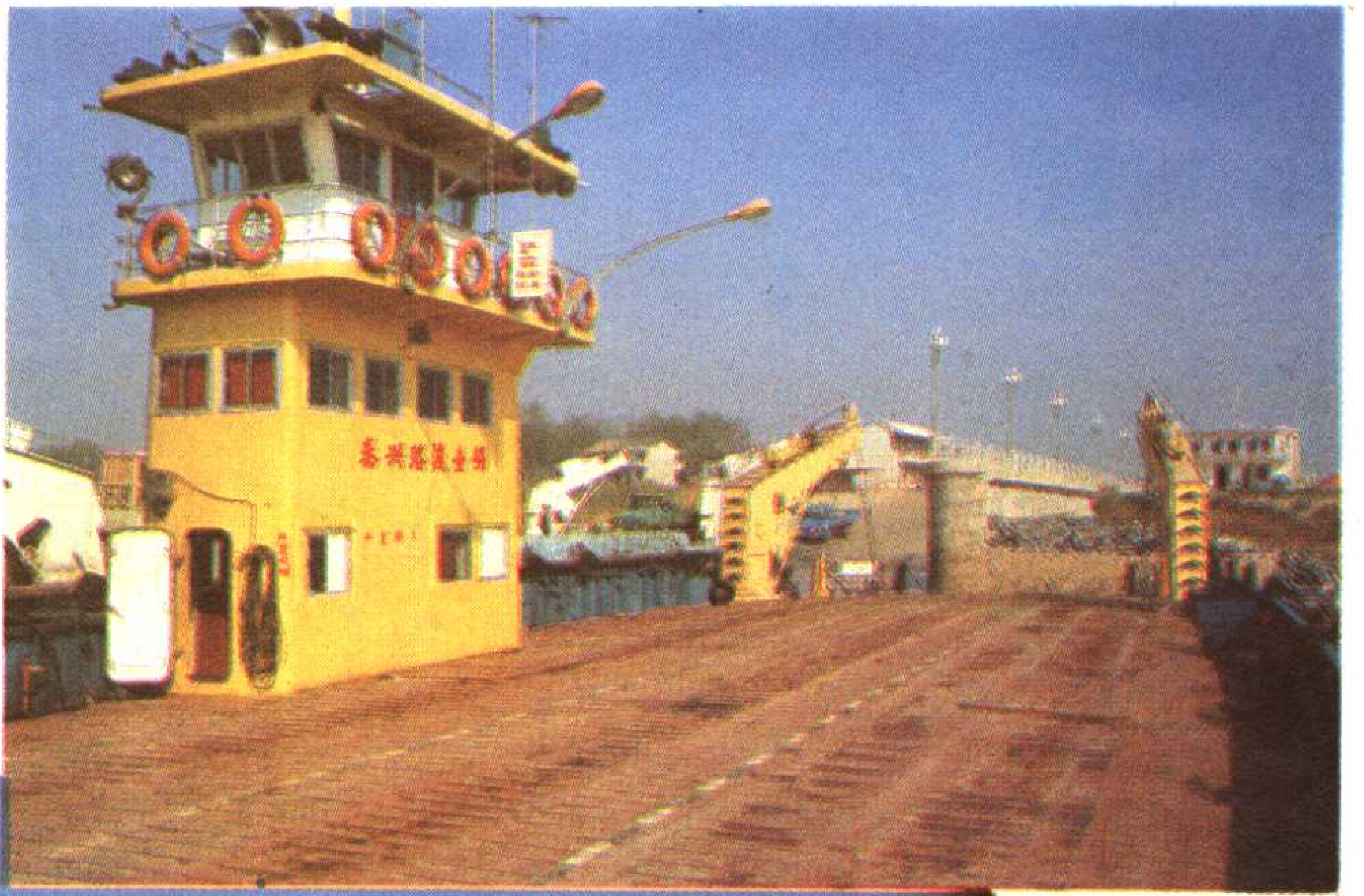
泰兴七圩汽渡口
