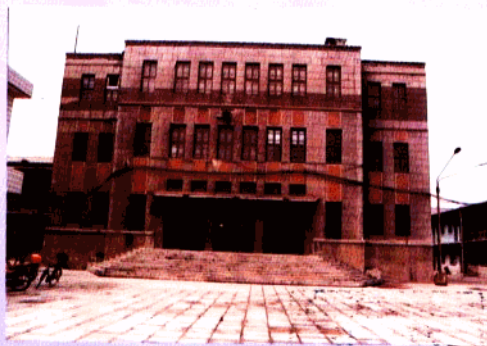
唐山钢铁公司俱乐 部因地基为轻亚粘 土、现浇钢筋混凝 土柱及圈梁、木质 轻屋顶。震后，外墙 裂缝依然可见，经 维修仍正常使用。
