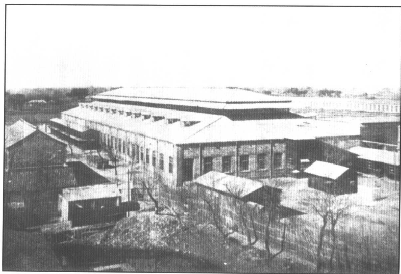
大生纱厂(一厂)于 1895 年筹建,1899 年建成。此为厂房外景。
