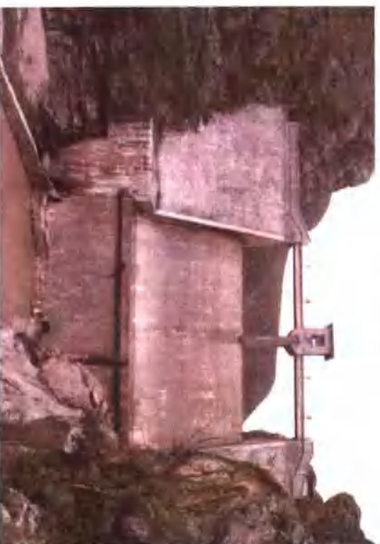
华亭县王峡口水库
