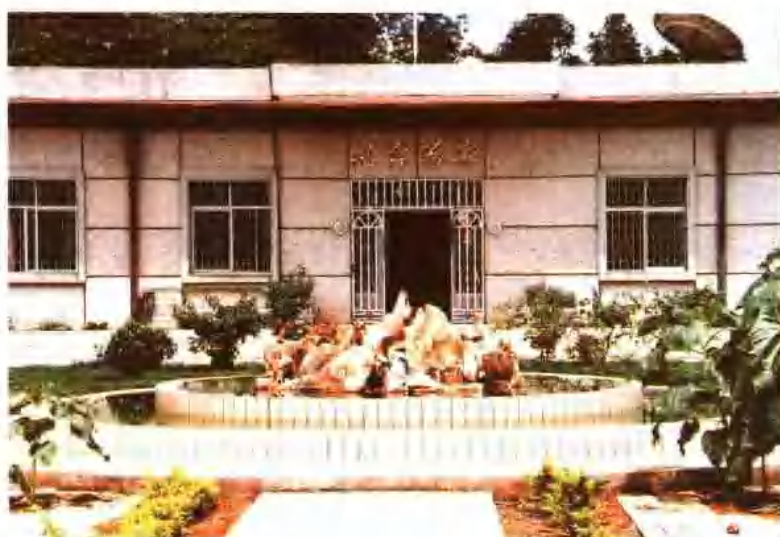
耿马中波台建于1986年。图为耿马中波台机房。
