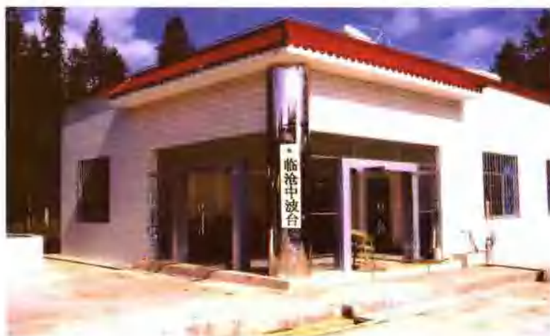
临沧中波台(699台)创建于1969年,曾几度搬迁重建。图为2005年新建的中波台机房。
