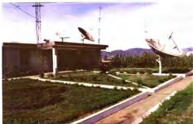
沧源中波台建于1991年。图为沧源中波台机房。
