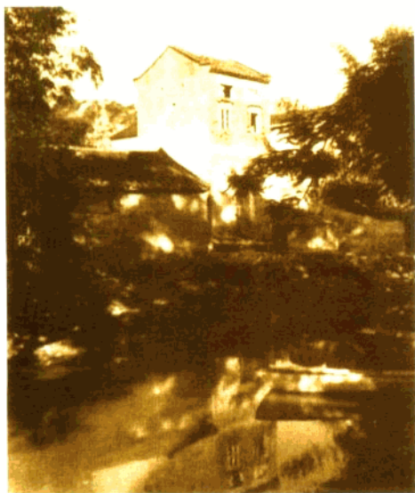
1945年1月18日，东江纵队第一支队攻克东莞水乡伪军据点高埗炮楼，解放高埗。图为高埗炮楼旧址。
