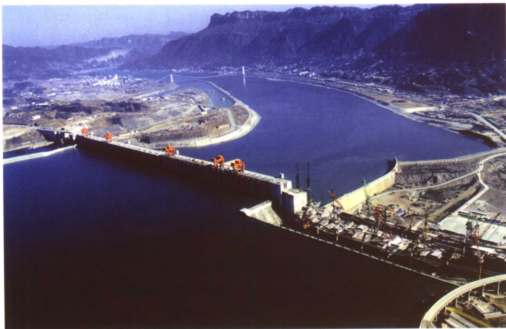
蓄水后的三峡大坝，左岸挡水建筑物已完成，右岸正在施工(2005年5月新华社记者拍摄) ■
