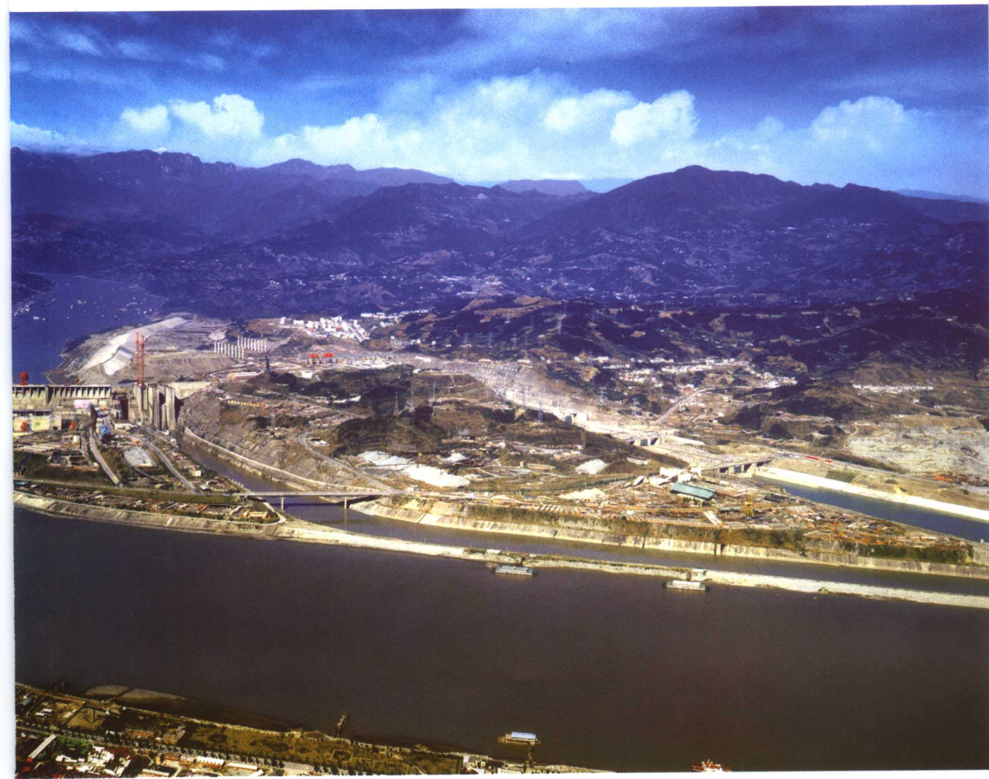
建设中的三峡工程全景 ■
