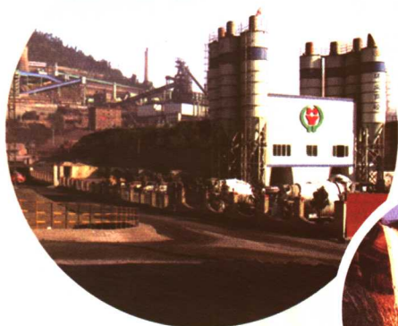
商砼混凝土拌合楼
