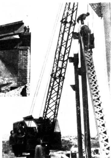
19. 白水河大桥的穿式桁梁采用就地拼装在吊 装杆件 →
