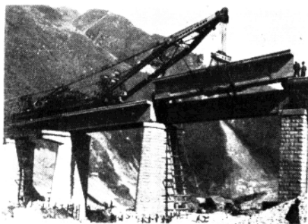
18. 架桥机架設钢筋混凝土T形梁 ↑
