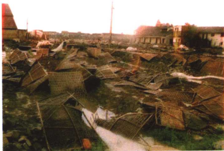
1990年8月31日,9015号台风对绍兴砖瓦厂造成重大损失
