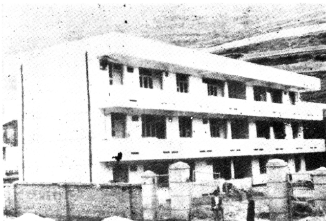
正在加紧施工中的松潘县计划生育指导站
