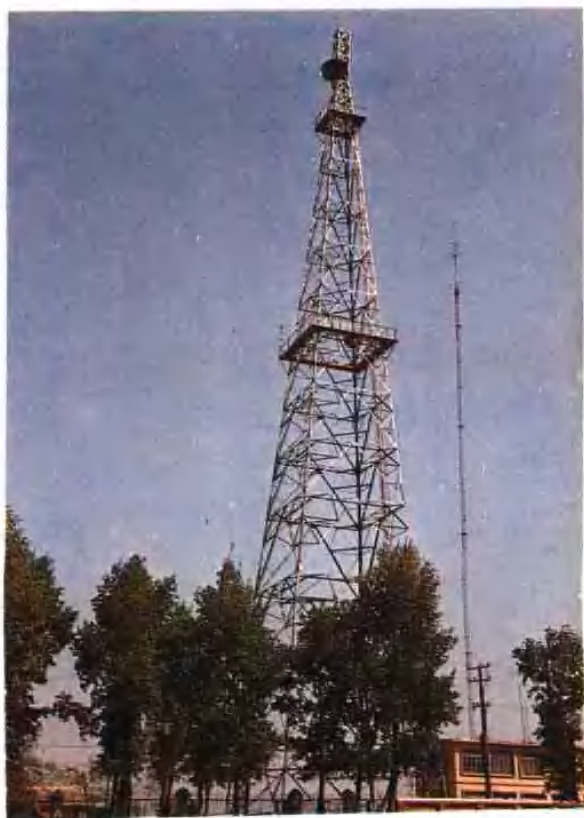
1 拜泉县电视转播台电视接收塔
