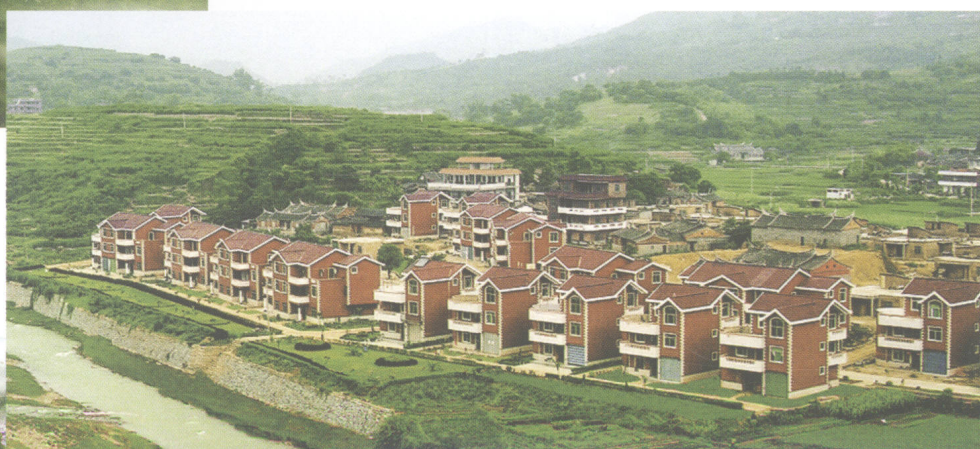
南安市英都镇溪益住宅小区
