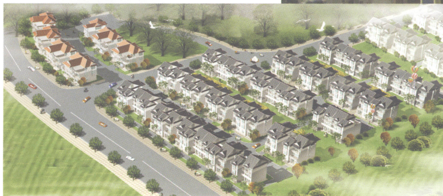
永定县坎市镇云景住宅小区
