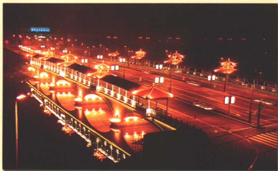
鼓楼大桥夜景
