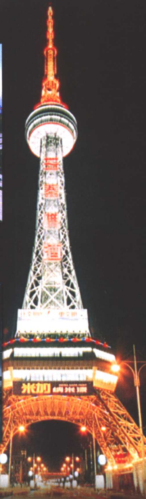
跨街广播电视塔
