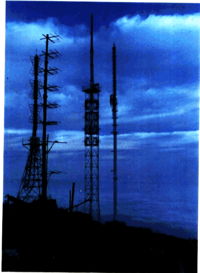
► 建在海拔2119米高的雾灵山顶上的50转播广播、电视发射塔
