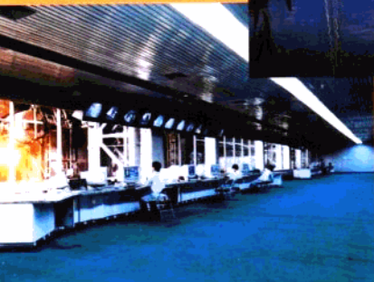
▽首钢第三炼钢厂主控室
