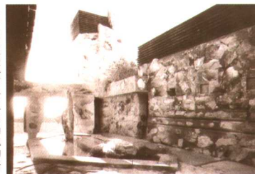
7-1-20C 建筑材料取自当地的岩石，与混凝土共同浇筑而成
