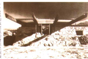
7-1-20E 构成建筑的材料是混凝土、石材与木材
