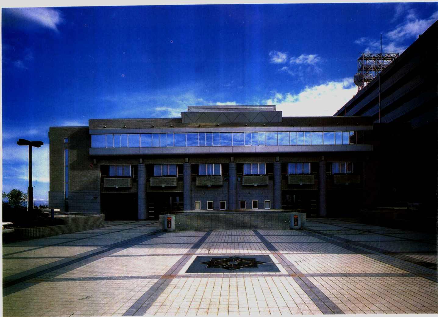
从广场看，正面是防灾大楼，右面是住宅楼
