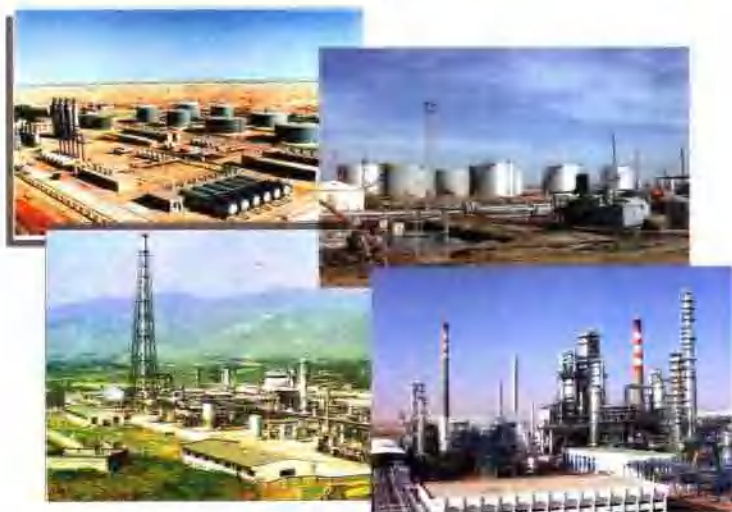
建设好地面工程
