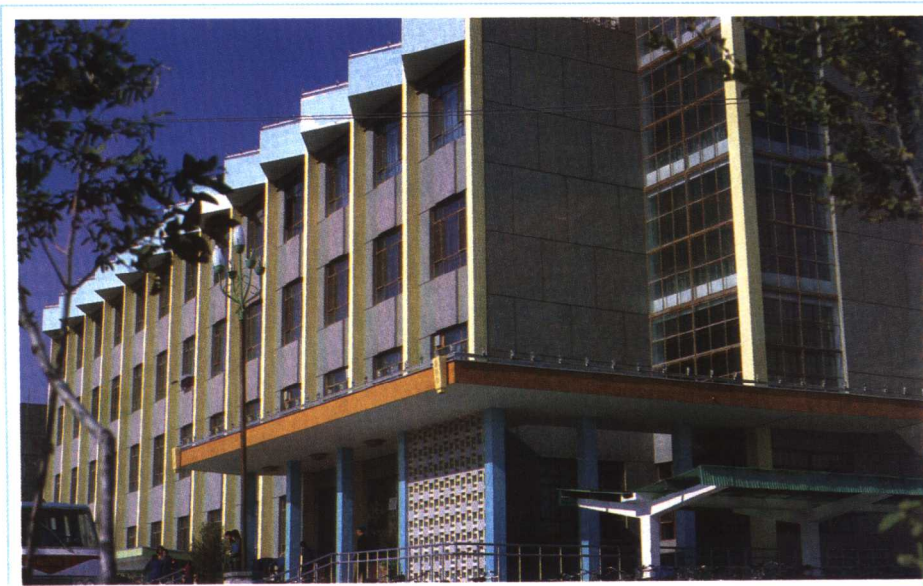
运输处办公楼
