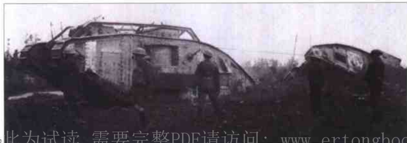
▼ 1918年8月，使用钢缆拖曳其他坦克的 MkV 型坦克（“雄性”）。该 MkV 型坦克车体前面涂有红白识别带。在其上部可以看到自救用方木使用的导轨。
