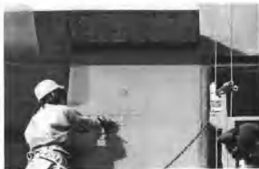
图 8 抹抗裂砂浆,铺压耐碱网格布
