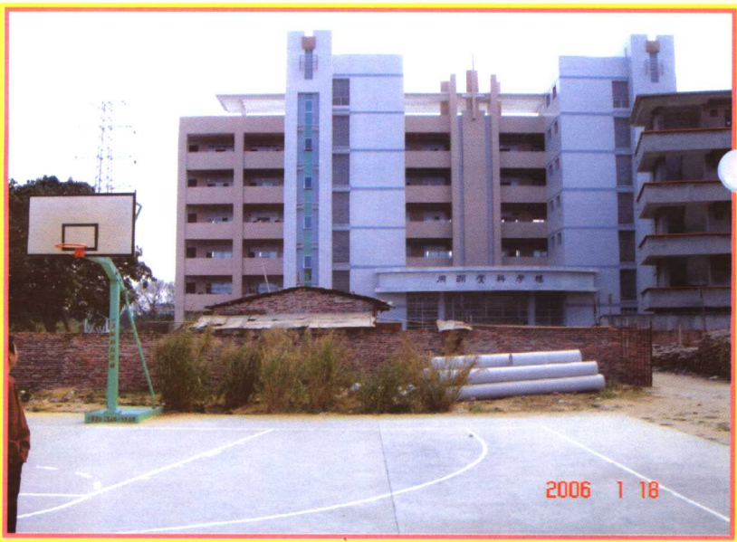
周润赏先生捐建的开侨中学周润赏科学馆即将竣工
