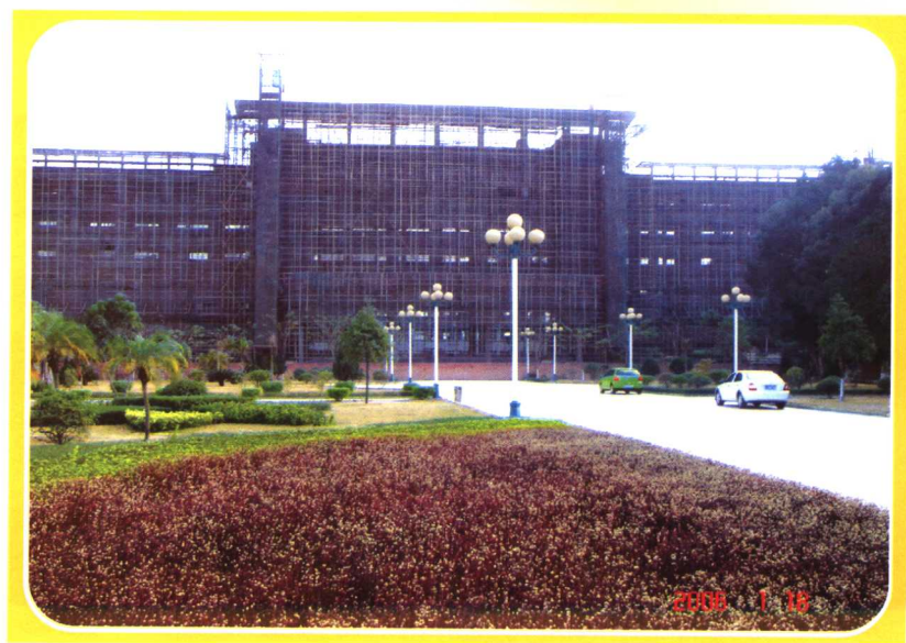
开侨中学“方君学伉俪教学实验大楼”正在紧张施工中
