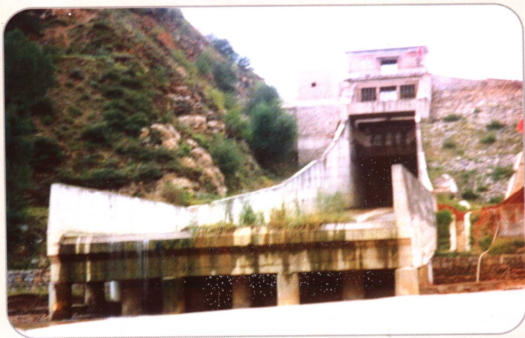
▷ 米家寨水库深孔泄洪闸
