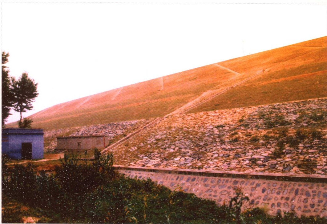
△神山水库涵洞出口
