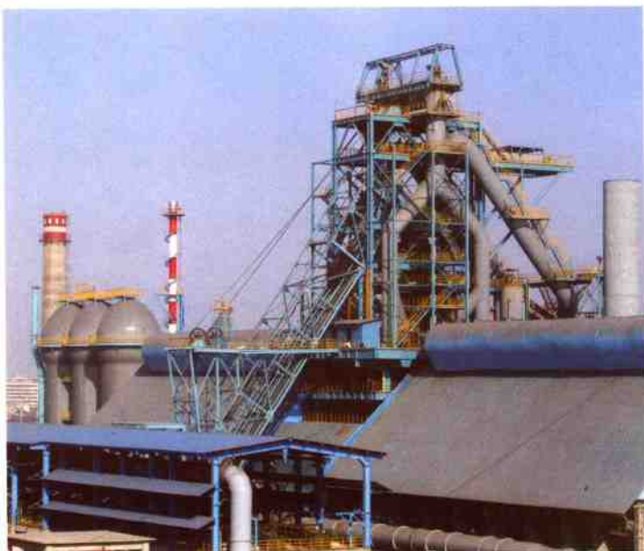
鄂钢炼铁厂 1080m 3 高炉
