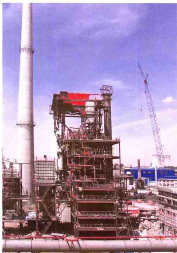
建设中的焦化公司干熄焦工程
